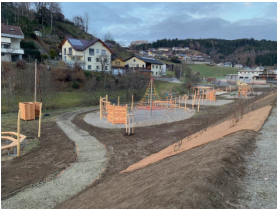
Die Spielgeräte wurden bereits errichtet und können bereits benutzt werden
